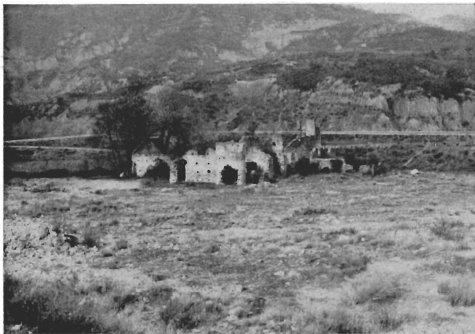
FIG. 5 — RUDERI DEL CONVENTO VENTRILE (XIV SECOLO) PARZIALMENTE COPERTI DA DEPOSITI ALLUVIONALI.
